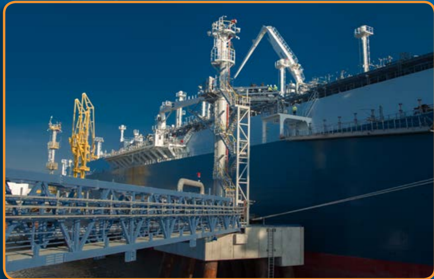
ESTONIA - KLAIPEDOS LNG - اولین ترمینال گاز مایع که مجهز است به یک سازه ساخت شرکت VERHOEF که قسمت بالایی آن دارای یک سیستم کنترل آتش و یک نردبان تلسکوپی برای دسترسی به کشتی های حامل گاز مایع میباشد
