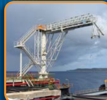
ستونهای مجهز به پلکانهای تلسکوپی که در موازای خط لنگر گاه جاسازی شده اند - بندر Port Valdez - Alaska
